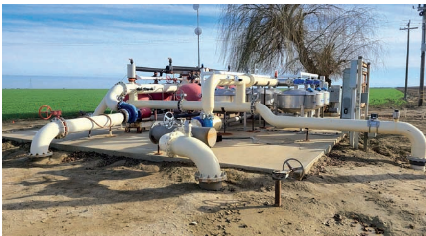
Filteračné stanice Azcal sa využívajú na dodávku vody pre plodiny na poliach s rôznou veľkosťou.
