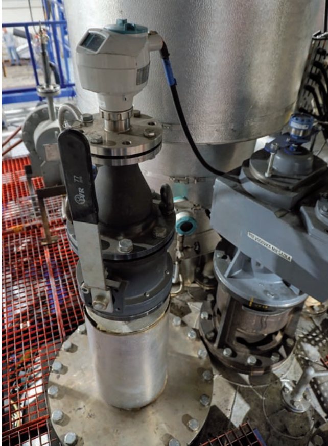
Meranie výšky hladiny v reaktore s teplotou okolo 450 °C, vysokým tlakom, bublajúcim a peniacim povrchom roztaveného plastu či pohybujúcim sa miešadlom sa podarilo vyriešiť pomocou radarovej technológie.
